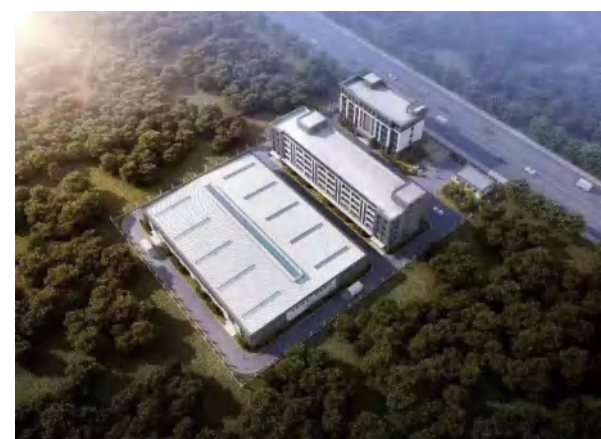
>>> 树顺新建厂区
